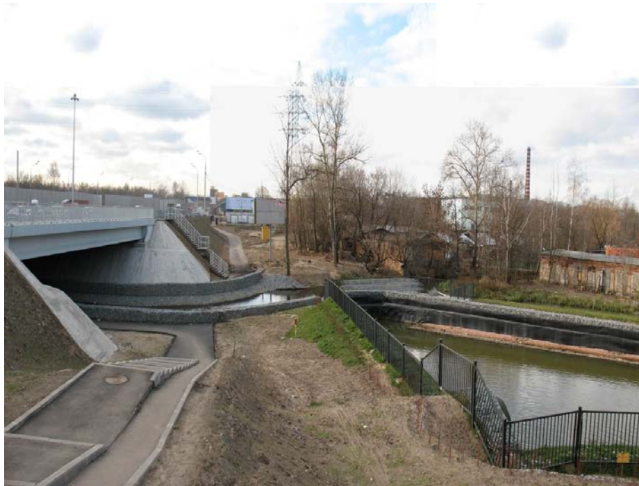
Рисунок 7- Пруд-отстойник с использованием габионов
