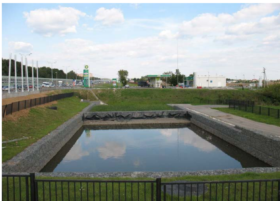
Рисунок 6 – Пруд-отстойник каскадного типа с использованием габионов
