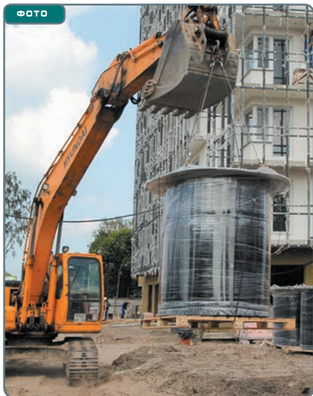
ОДИН ИЗ ВОЗМОЖНЫХ СПОСОБОВ ВЫГРУЗКИ И УСТАНОВКИ ФИЛЬТРОПАТРОНА НА ОБЪЕКТЕ СТРОИТЕЛЬСТВА
